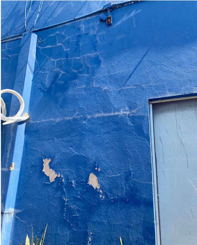
FACHADA LATERAL DIREITA
